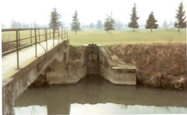
Presa di inizio Bazzera in località Mezzaluna. Sullo sfondo i campi da golf di Martellago.
