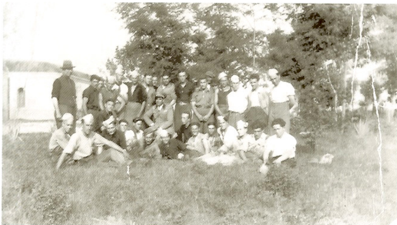
Forte Mezzacapo, operai addetti al ripristino granate. Aprile 1933.
